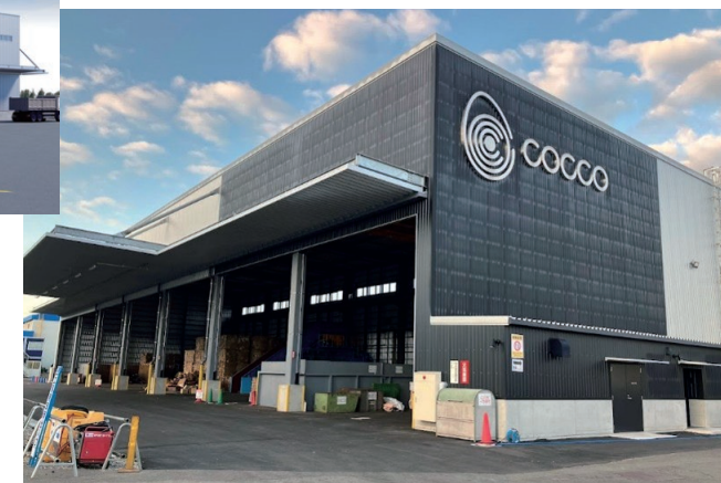
東広島リサイクルセンター
