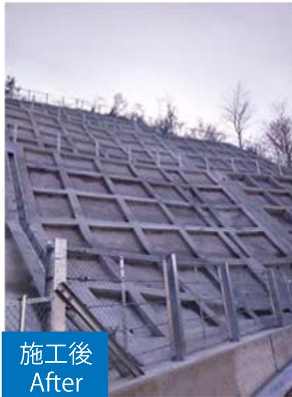
降雨や地震などに伴って発生するがけ崩れ等の災害を防止するため、斜面の保護・崖などの崩壊を止める擁壁等を整備する工事を行いました。
